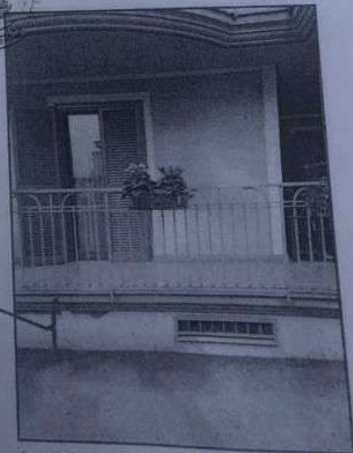
Foto 2: Particolare dell'appartamento posto al piano terra
